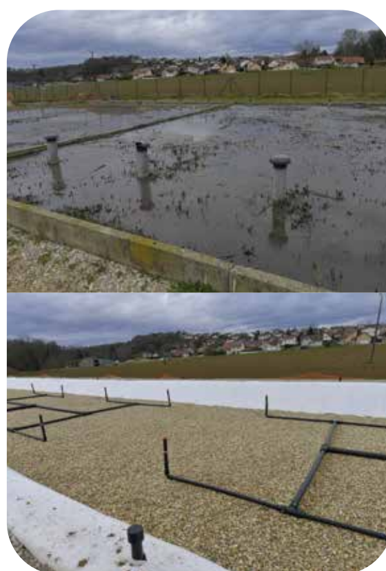
Nouvelle station de Torpes en cours de travaux - rampes d'aspersion d'eau en cours de pose
