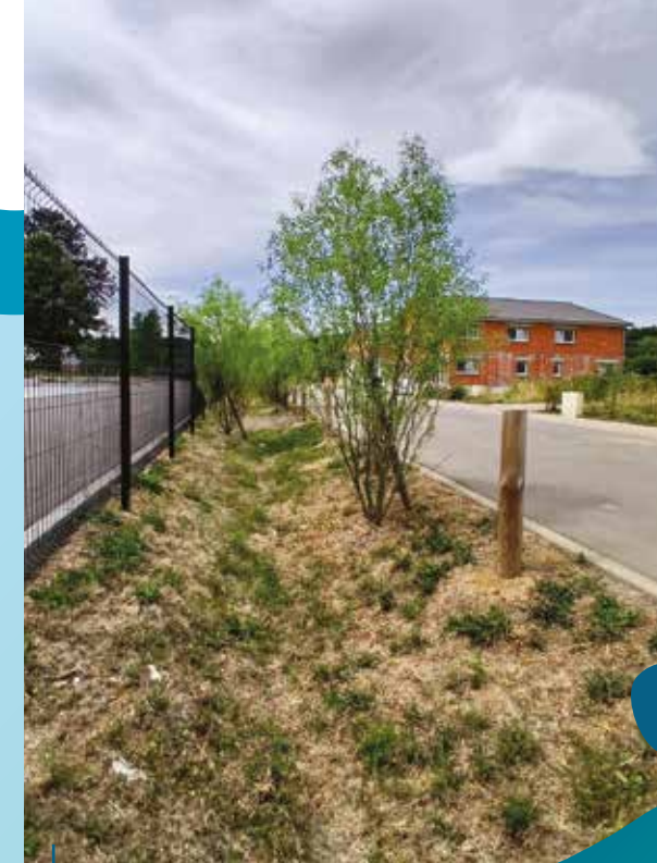
Noue d'infiltration Commune de Châtillon-le-Duc
