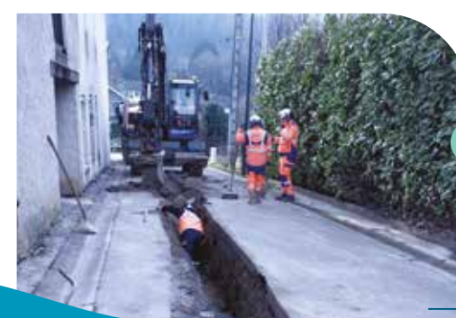
Conduite en cours de pose
